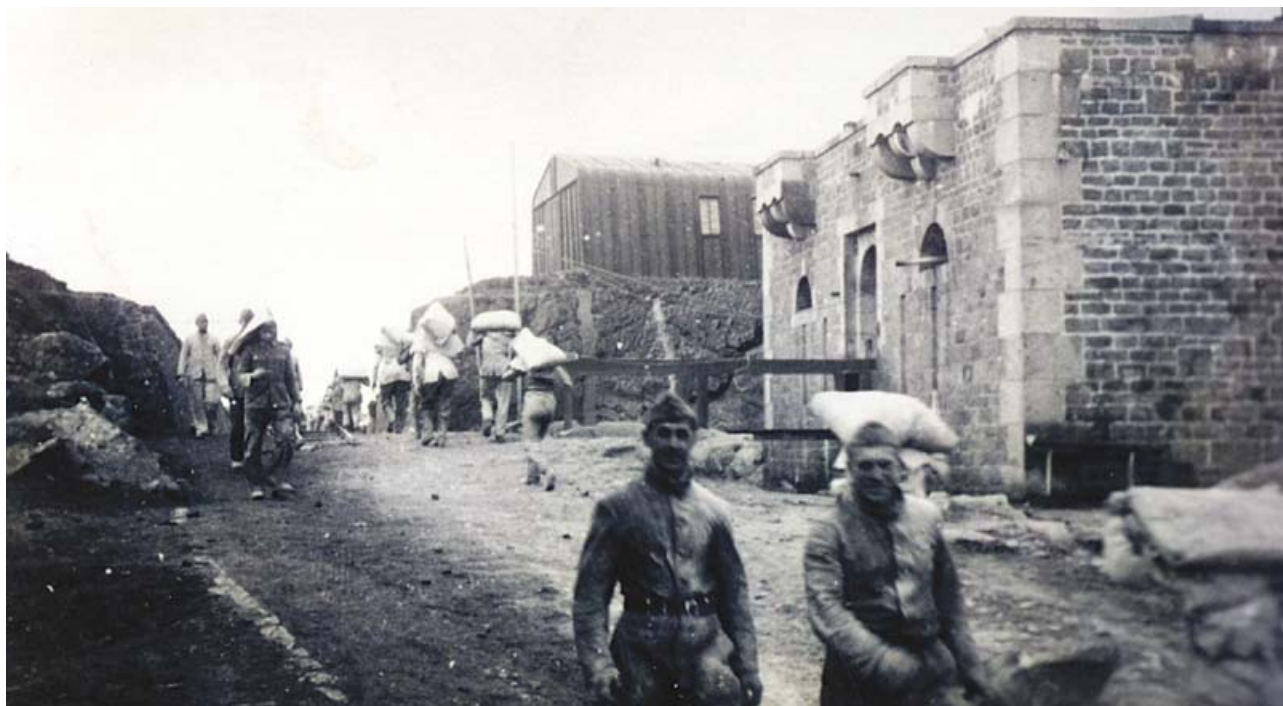
En 1860-1861, deux fortins parallélépipédiques de type 1846 avec entrée et pont-levis sont construits sur l'île. (Photo du soldat Otto Koch)
